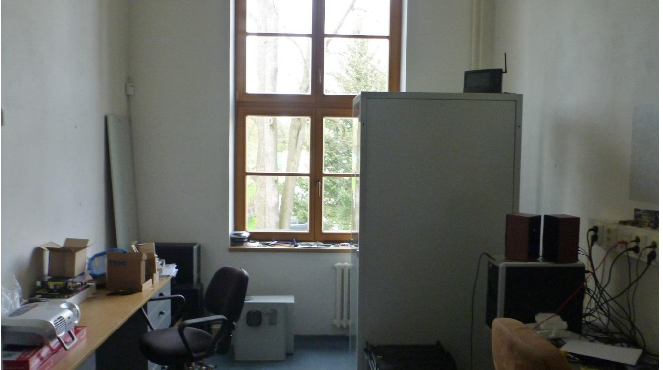
Serverovna před rekonstrukcí.
