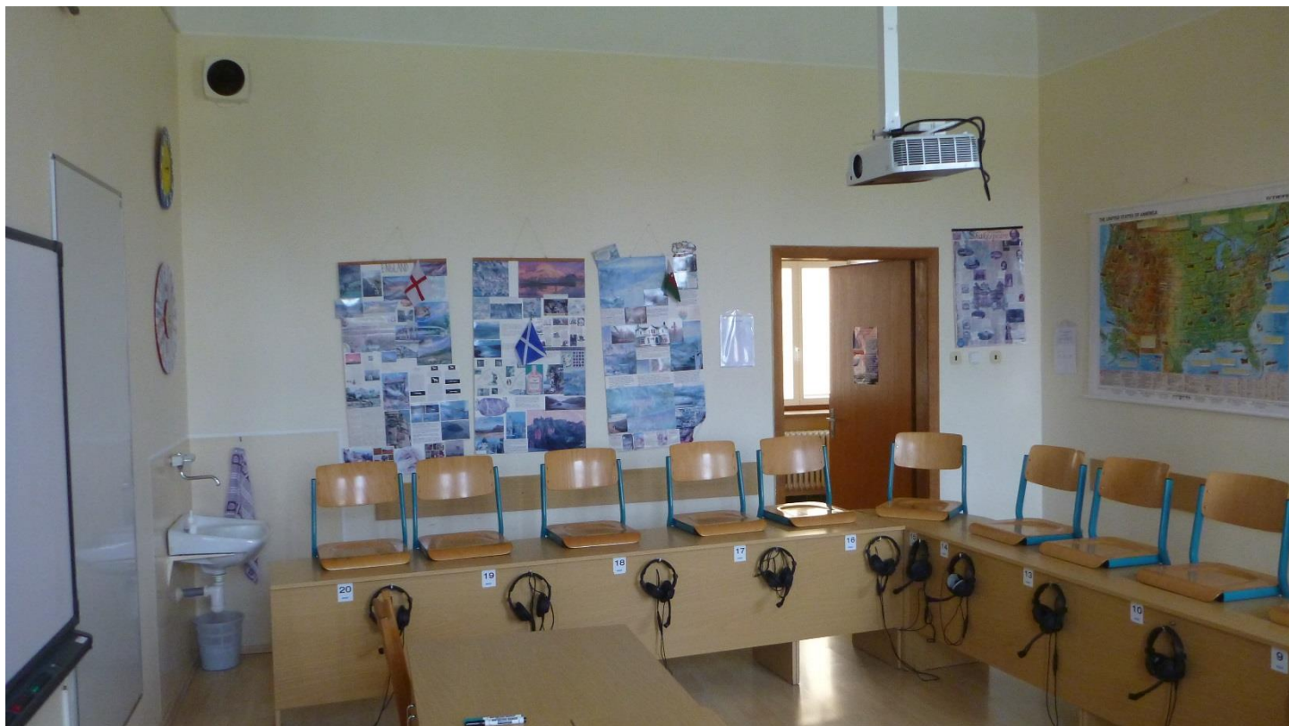
Jazyková učebna před rekonstrukcí.
